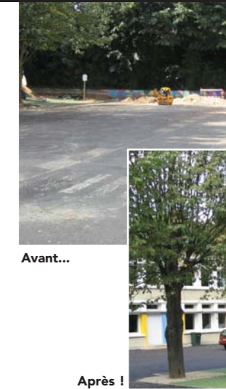
École maternelle du Guichet : réfection complète de la cour, mise en place d'un jeu sur sol souple. Coût : 60 000 €.
