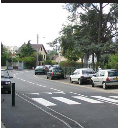
Avenue de Montjay : création d'un plateau surélevé devant le groupe scolaire. Coût : 21 000 €.
